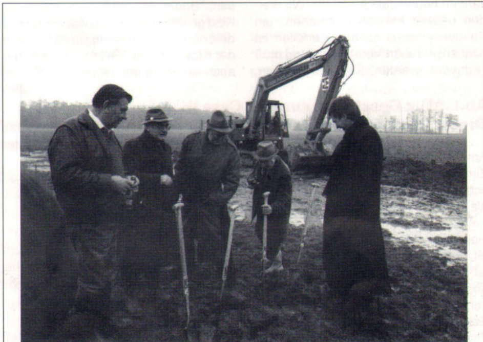
Den ersten Spatenstich am Naturschutzprojekt Lüntener Feld tat der Präsident der Nordrhein-Westfalen-Stiftung Dr. Diether Deneke in Anwesenheit hoher Amtsträger aus der Region. Auf dem 6,5 Hektar großen Areal „Lüntener Feld“ setzt die Firma Haddick einen 20-to-Raupenbagger Typ 1088 von Case Poclair für den naturnahen Ausbau von Fluchtgebieten ein.
