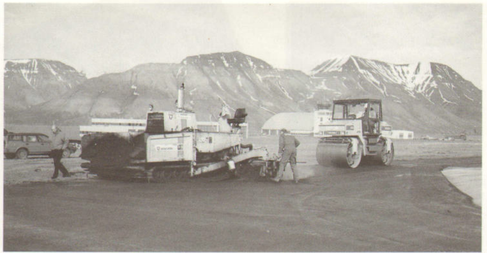
Die einzige Start- und Landebahn des Flughafens Longyearbyen auf Spitzbergen erhält eine neue Deckschicht aus Asphaltbeton mit eingebettetem Armierungsgitter. Maschinen, Geräte und Baustoffe wurden vom 1.100 Kilometer entfernten Festland per Schiff angeliefert
