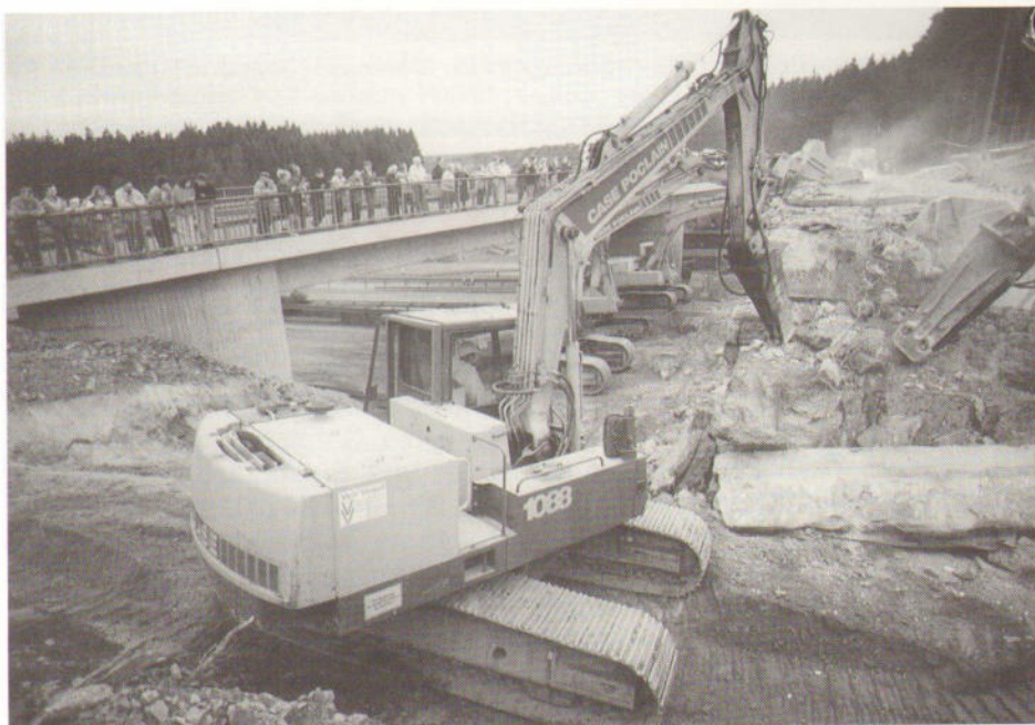
Acht von neun Baggern beim Großinsatz Brückenabbruch auf der A9 kommen von Case Poclair.
