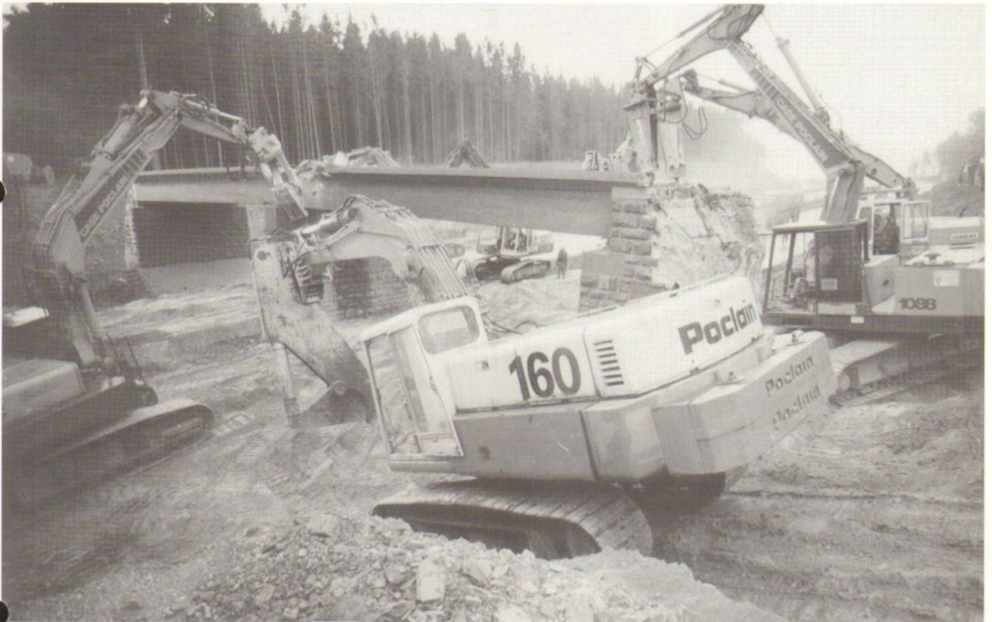
Die Bagger bringen sich in Position. Sofort beginnt ein Crescendo von Hydraulikhämmern, Dieselmotoren und Betonbrechern.
