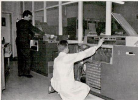
fehlerfrei geschrieben, mit Anschrift, Fälligkeitsdatum, Zahlungsbedingungen usw. Diese Anlage heißt fachmännisch ausgedrückt: IBM 1401, mit 4 Magnetbandeinheiten. Das Magnetband ist auf einer Spule aufgewickelt und ungemein empfindlich.
