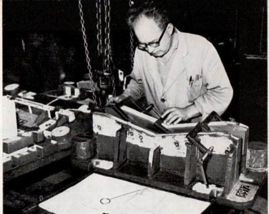
24. Werkzeugschlosser: Einpassen von Formstücken in einer Warmbiegevorrichtung.
