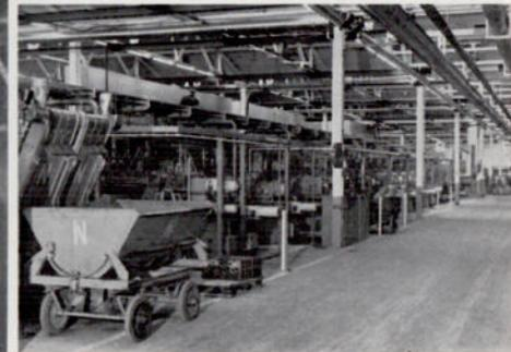
Oben: Blick in den Gießereihof. Rechts sehen wir die neuen Silos mit Kernsand, anschl. die Kernmacherei und die Sandaufbereitung. Links die auf diesem Bild noch nicht fertige Chargieranlage für Kupolöfen.
