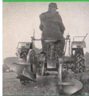
Der Farmall D-2 Dieselschlepper mit Anbauwechselflug.
