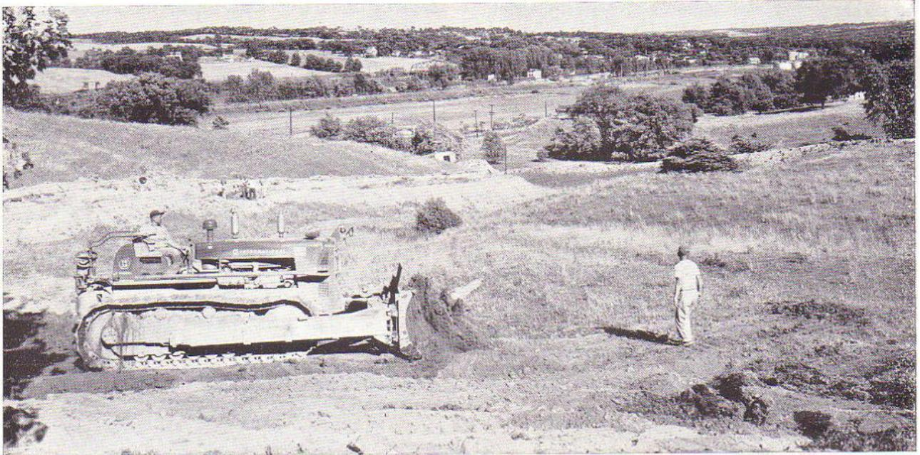
Beim Bau eines neuen Auto-Schnellweges, der die beiden Städte New York City und Buffalo im Staate New York miteinander verbinden soll, wurden für Planierungsarbeiten auch die bewährten IH-Maschinen eingesetzt. Hier ein TD-24 Raupenschlepper bei den Vorarbeiten zur Planierung des Straßenbettes. In wenigen Monaten werden die Wälder und Hügel im Hintergrund nichts anderes sein als ein Teil der neuen Straße.
