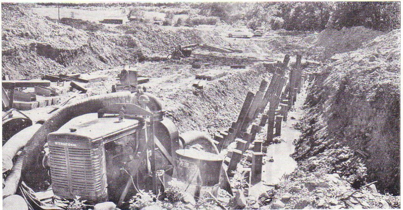
Unser Bild zeigt einen der stationären IH-Motoren als Kraftquelle in Verbindung mit einer Grosspumpe. Diese Kombination ermöglichte während des Straßenbaues die Entwässerung von Brückenfundamenten innerhalb weniger Stunden. Auch in den Neusser IH-Werken werden stationäre Dieselmotoren hergestellt, die sich durch eine besonders hohe Kraftabgabe auszeichnen. Zur Zeit sind folgende Modelle lieferbar: DU 66-D (2-Zyl.), DU 99-D (3-Zyl.) und DU 132-D (4-Zyl.).
