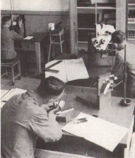
Die Ausgangsstation ist der Anreißraum, welcher mit den heutigen Feinmeß-Werkzeugen aller Art versehen ist. Schmiede- oder Gußteile werden als erste Anhaltstücke zeichnungsgerecht kontrolliert, bevor sie zur Fertigung für die einzelnen Bearbeitungsstätten freigegeben werden.
