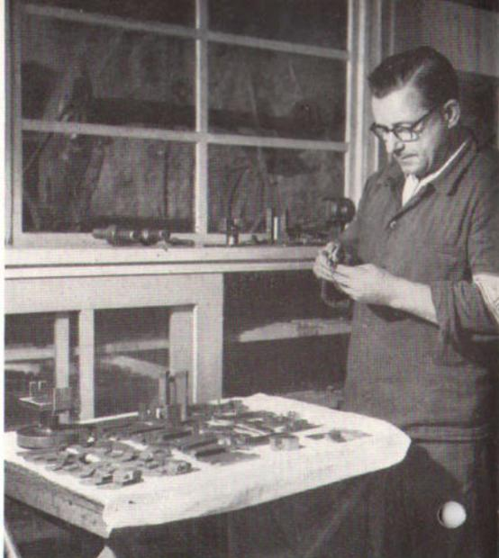
Diese Aufnahme zeigt die mehr als 50 Lehren, die in der Zwischenkontrolle bei der Abnahme eines kompletten Knüpfhakens als fertiges Einzelteil vor dem Zusammenbau gebraucht werden.
