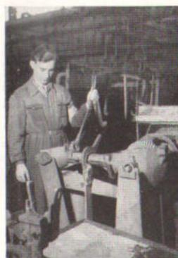
Eine der letzten Kontrollen ist die Überprüfung des Lagerhausbestandes. Auf dem Inspektionssturz werden dem Lagerhaus wahllos entnommene Maschinen-Einheiten (Rollis) zu fertigen Maschinen zusammengesetzt und Laufversuche durchgeführt, bei denen Funktion, Kraftbedarf und Geräuscharmut besondere Beachtung finden.
