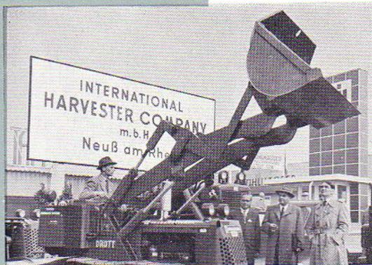
Der INTERNATIONAL BTD-6 mit DROTT Ladeschaufel. Eine Maschine mit vielseitigen Einsatzmöglichkeiten.
