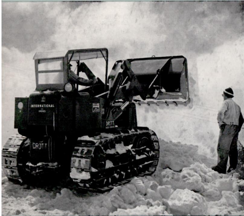
Überall dort, wo höchste Anforderungen an die Leistungsfähigkeit von Maschinen gestellt werden, haben sich INTERNATIONALE Raupenschlepper ausgezeichnet bewährt. Hier eine BTD-6 Raupe mit DROTT Ladeschaufel bei Schneeräumungsarbeiten am St. Gotthard.
