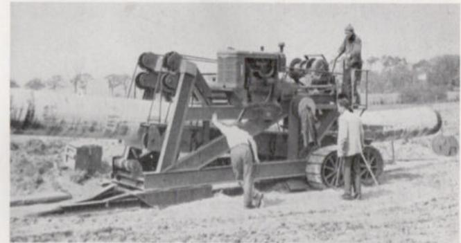
Nach dem Verlegen der Rohre werden die Gräben mit einem „backfiller“ zugeschüttet.
