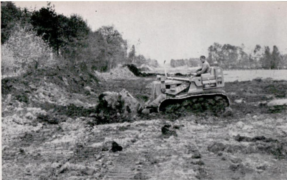
Auf 20 m Arbeitsbreite schürfen INTERNATIONAL DROTT Laderaupen den Mutterboden aus dem Bereich der Baulinienführung.
