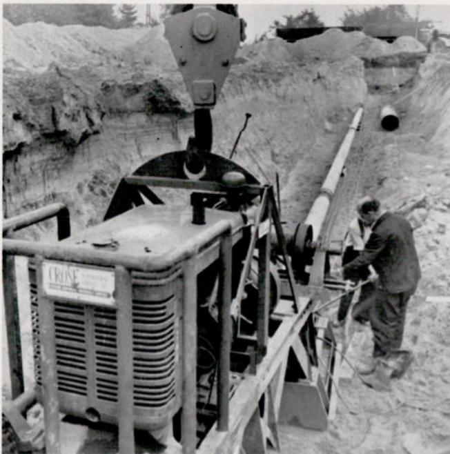
Bis zu 60 m breite Straßen und Eisenbahndämme können mit diesem Bohrer unterhöhlt werden, ohne daß der Verkehr unterbrochen werden muß. Als Antriebsaggregat dient der INTERNATIONAL Dieselmotor U 264
