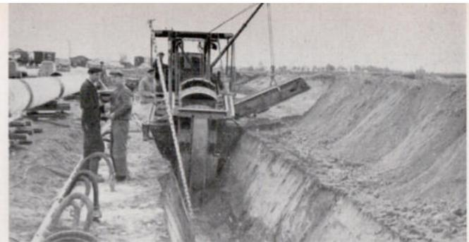
In einer Schicht von 10–12 Stunden wirft dieser Schaufelradbagger einen 2.000 m langen Graben aus. Eine Rohrbiegemaschine, angetrieben durch ein IHC-Motor, bereitet die entsprechenden Rohrstücke für die Dücker vor.
