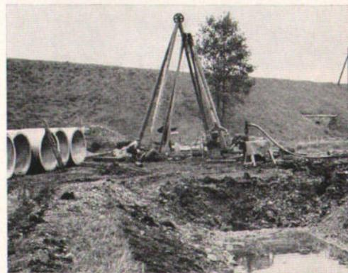
Rohre werden in einen Damm getrieben, damit die großen Wassermassen abgeleitet werden können.
