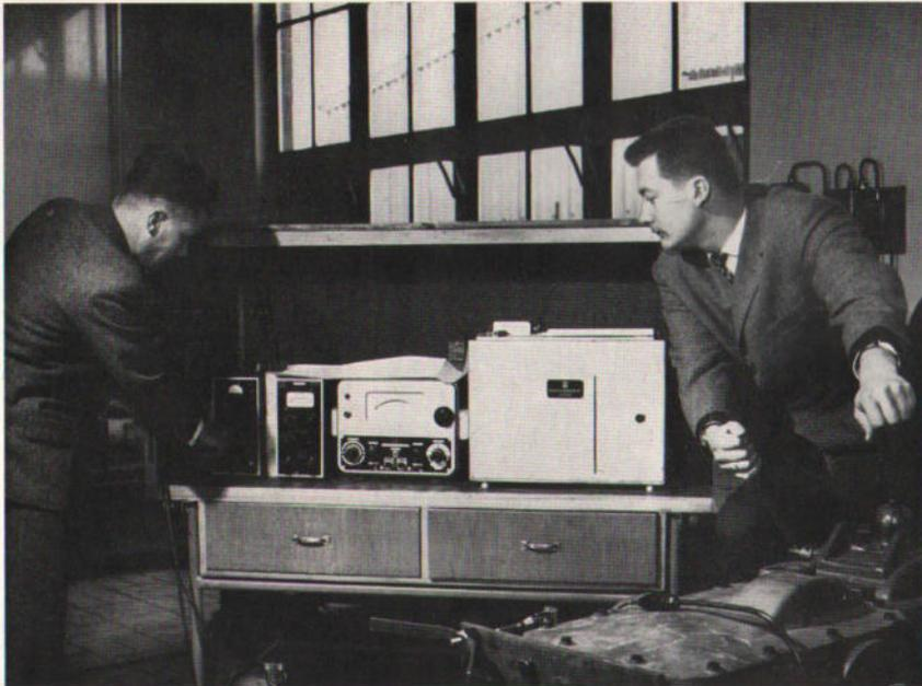
Schwingungserzeugung an einer Hinterachse mit Radschlüssel und Messung der Resonanzen. Durch Schwingungsaufnehmer, Meßbrücke und Oszillograph wird die Schwingung beobachtet (unten).
