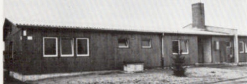
Für 244 ihrer türkischen Mitarbeiter hat die International Harvester Company diese Wohnheime an der Floßhafenstraße in Neuss errichtet.
