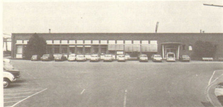
Konstruktionsgebäude des Entwicklungszentrums der IH in Neuss/Rhein.
