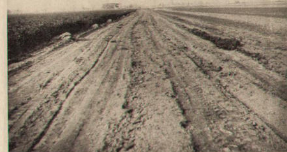
Ein Feldweg vor und nach der Bearbeitung mit dem Planierschild
