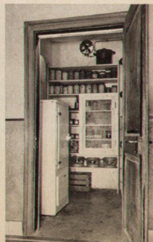
Eine Speisekammer mit Kühlschrank und Ventilator
