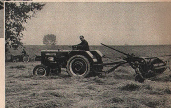
Zapfwellengetriebener Schwadenrechen in der Heuernte
