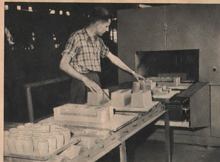
Beschickung des Hochfrequenz-Kerntrockenofens
