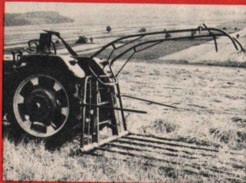
Der Heuschwanz wird an die Dreipunktaufhängung des Schleppers angebaut.
