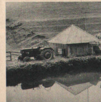
Die Pumpe im Pumpenhaus der Gülleanlage wird von der Riemenscheibe des McCORMICK-Schleppers angetrieben.
