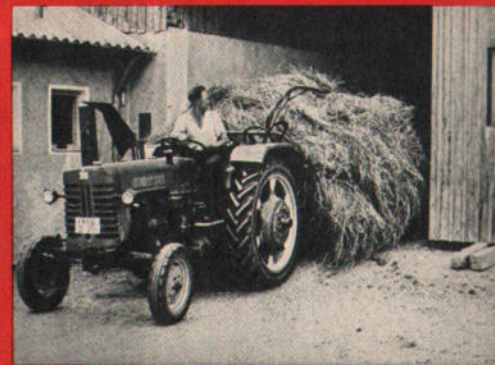
Rückwärts in die Scheune gesetzt und dann mit dem Heuschwanz unter der Ladung herausgefahren – das ist das ganze Abladen bei unserem Heuschwanzbauern.
